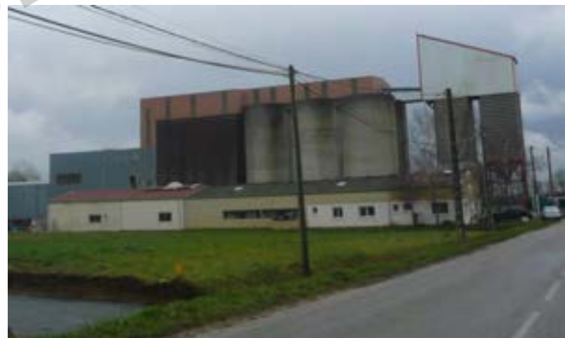
Silos à grains de la coopérative agricole Bourgogne du sud (siège social à Verdun-sur-Doubs) – Citadia Conseil
