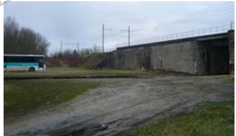
Friche ferroviaire - Saint-Bonnet-en-Bresse. Emprise 7ha, propriété foncière Réseaux Ferrés de France (RFF) – Citadia Conseil
