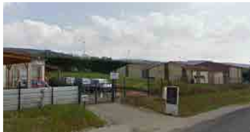
Site Caillon Mécanique – Zone d'activité de la Charbonnière à Cuiseaux – Citadia Conseil
