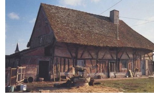
Ferme bressane. La Bresse bourguignonne, Ecomusée de la Bresse bourguignonne
