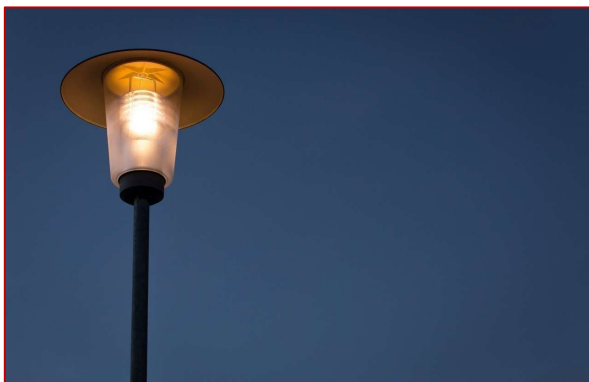
Amélioration énergétique de l'éclairage public
